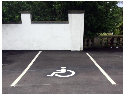
Den ny-etablerede invalideplads ved bagindgangen
